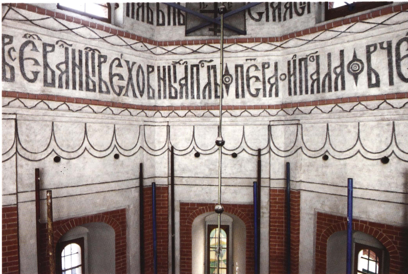
К статье Н. Н. Малышевой, А. А. Полюляха, Т. Г. Сарачевой «Новые сведения о голосниках собора Покрова на Рву в Москве». Рис. 2. Голосники в верхней части восьмерика центральной церкви собора. Фотография выполнена в процессе реставрации 2015 г.
