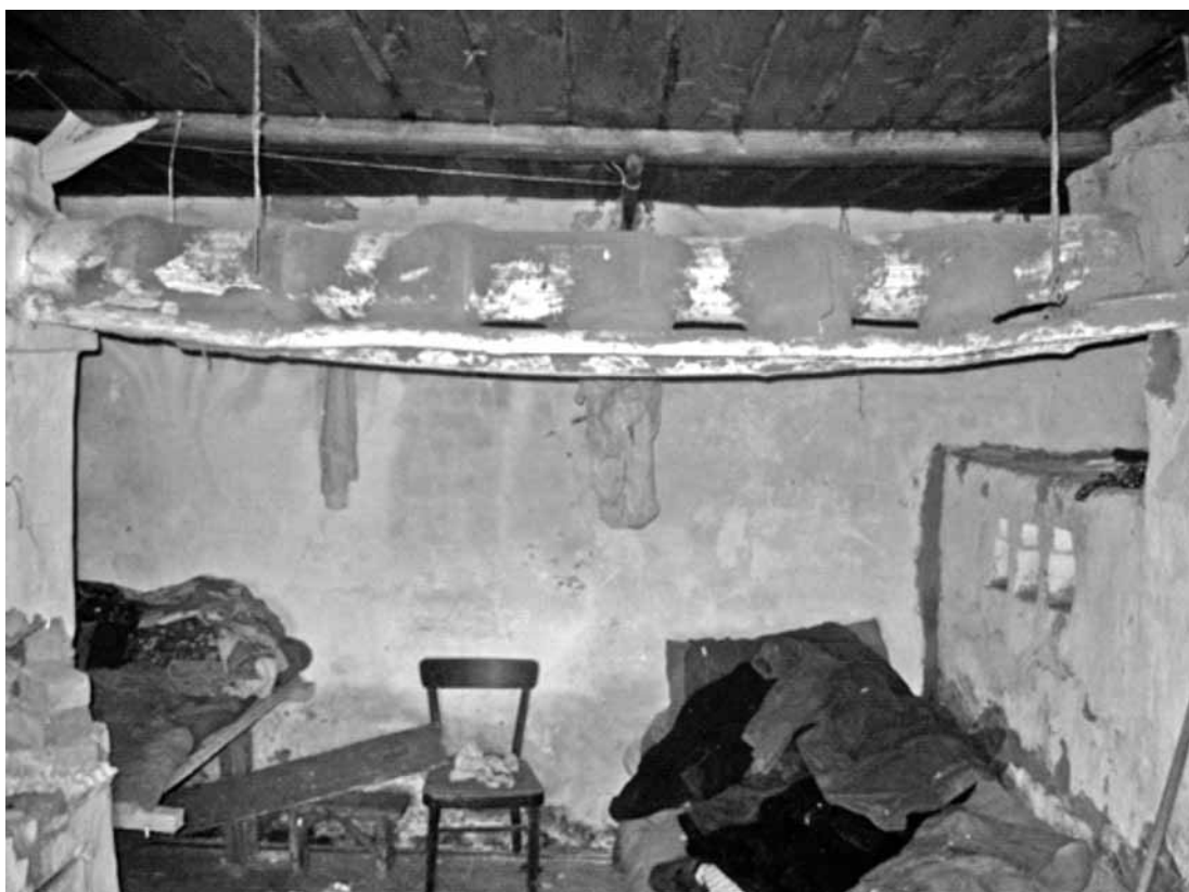
Рис. 4. Устройство горизонтального дымохода в доме. Дер. Хлуднево Думиничского р-на Калужской обл. (фото А. Г. Заборских? 2010-е гг.)
